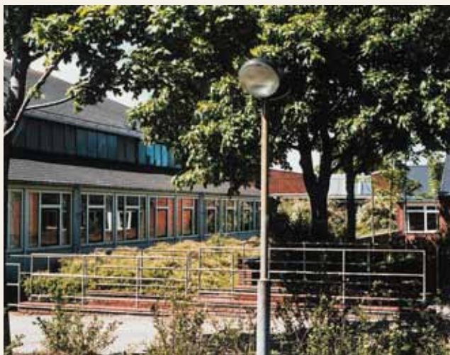
Mørkhøj Skole set fra Ilbjerg Allé, 2006.
